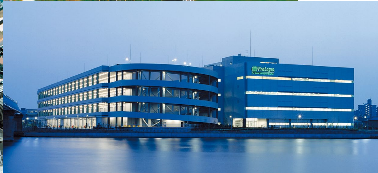
プロロジス横浜プロジェクト (神奈川県横浜市)
