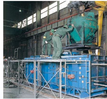
4 コンクリート打設
