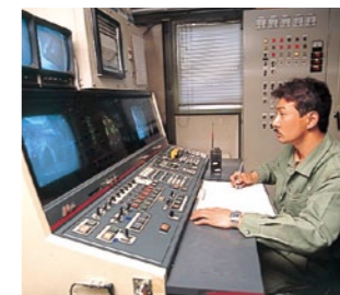
パッチャープラント操作室
