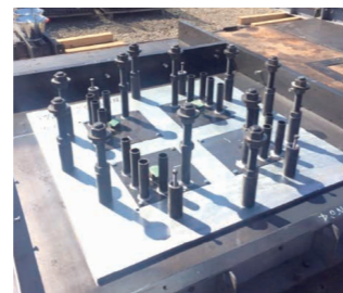
施工現場写真15
