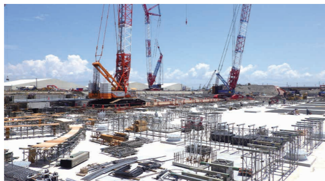
施工現場写真3
