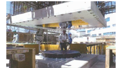
施工現場写真10
