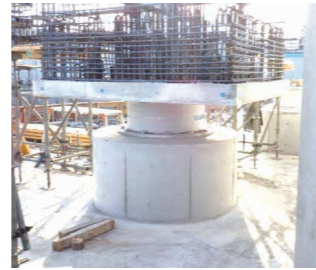
施工現場写真14
