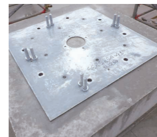
⑤下部基礎コンクリート打設完了
