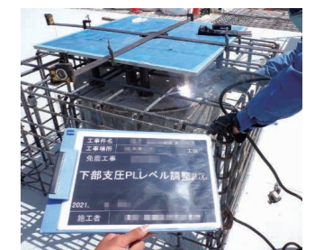
④下部プレート位置・高さ調整
