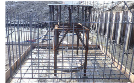
施工現場写真5
