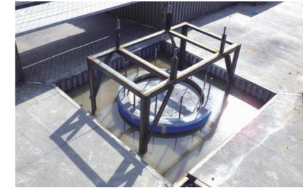
施工現場写真6
