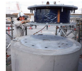
⑥免震装置据付
