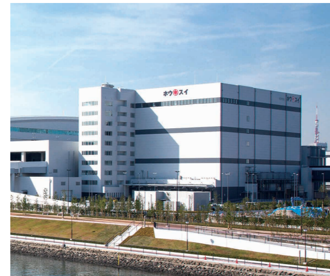
株式会社ハウスイ豊洲 新市場冷蔵倉庫
