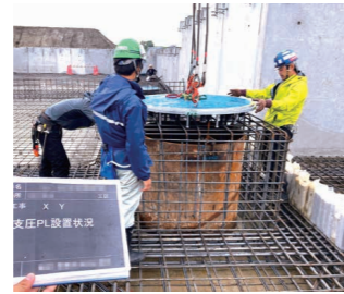
施工現場写真13
