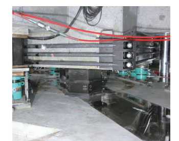
施工現場写真12
