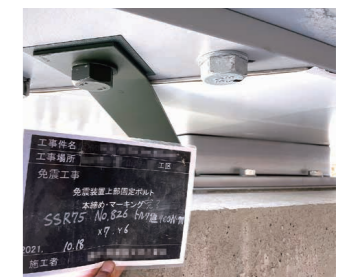
⑧免震装置取付完了
