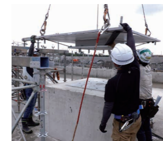
⑥免震装置据付
