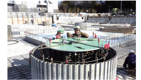
施工現場写真7
