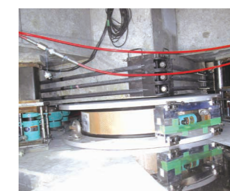
施工現場写真11
