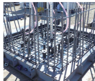
施工現場写真16
