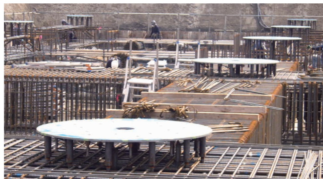
施工現場写真4
