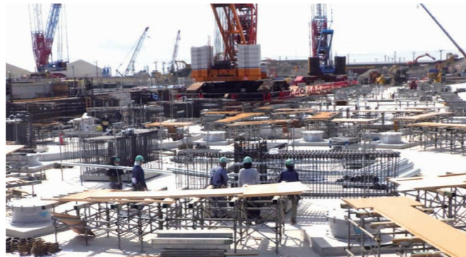
施工現場写真2
