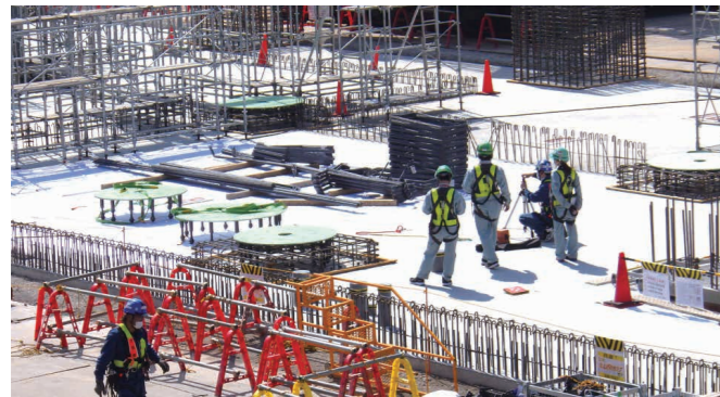
施工現場写真1
