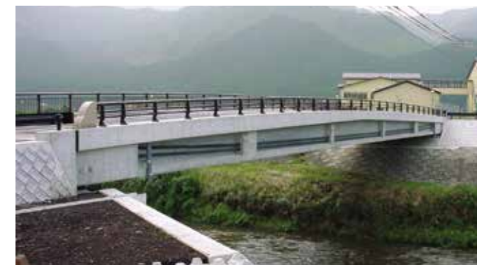
6.外ケーブル・緊張終了
