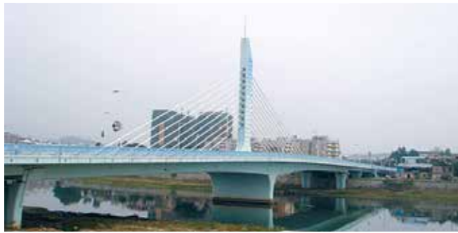
同安銀湖大橋 (中国:斜張橋)
