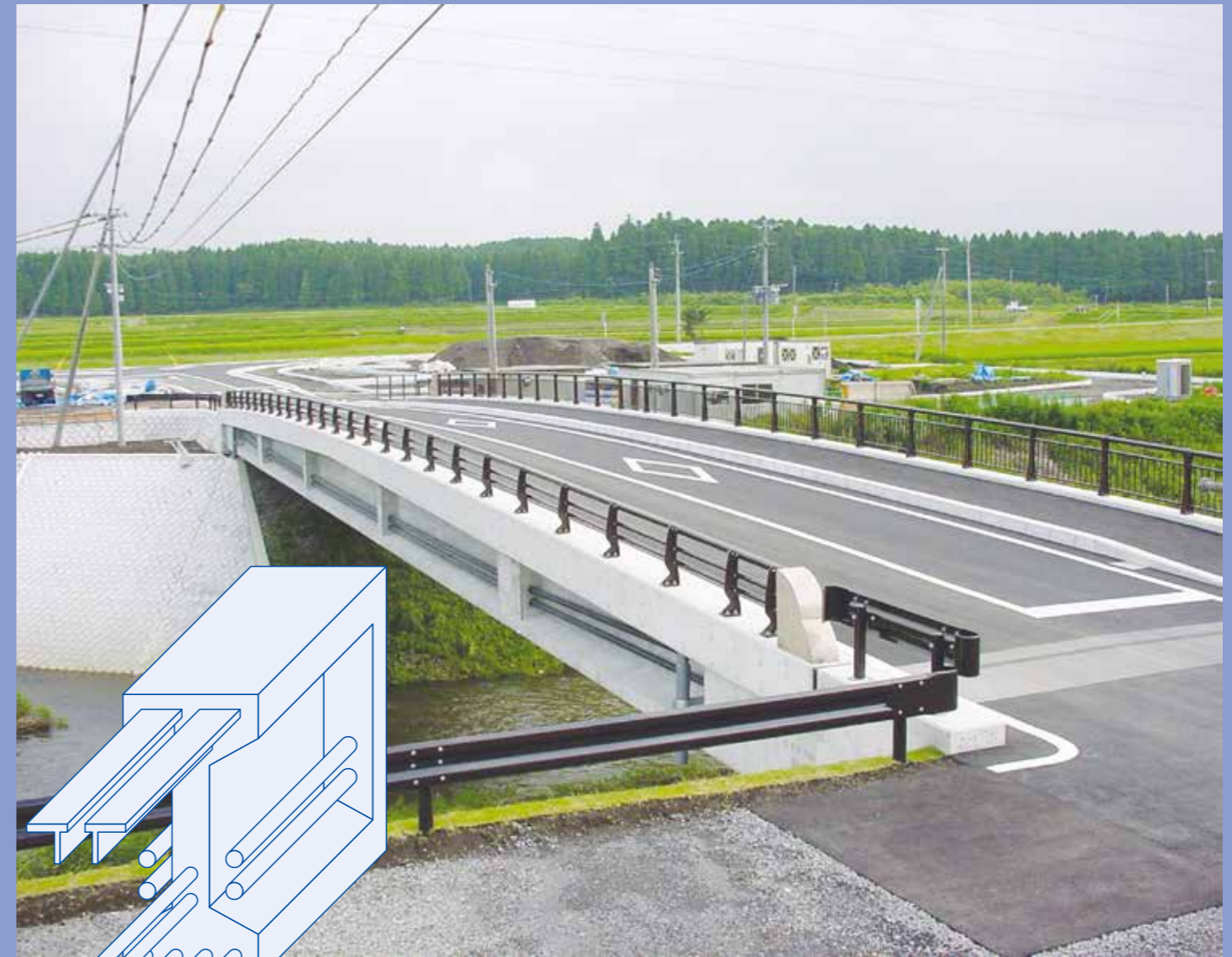
施工事例 / 跡ヶ瀬大橋 (熊本県)
