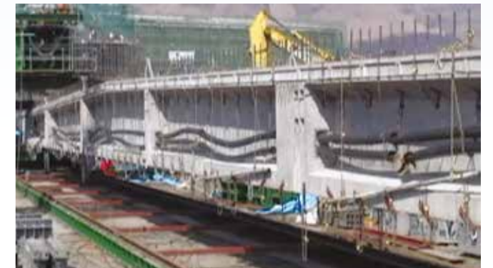
4.外ケーブルの配線状況
