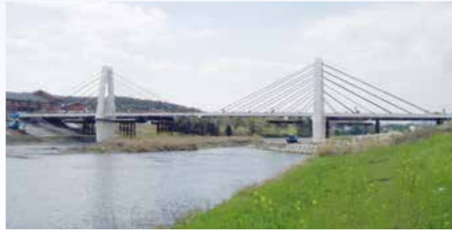
菊池川歩道橋 (熊本県:SPC合成斜張橋)
