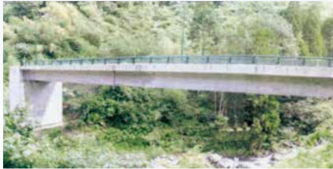
戸越鹿目2号線 (熊本県:場所打ち箱桁橋)
